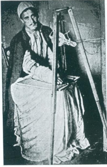
İlk defa dünyada iki Türk tıbbiyelisi tarafından harp yaralısına Röntgen tatbikatında kullanılan âlet (1897)
